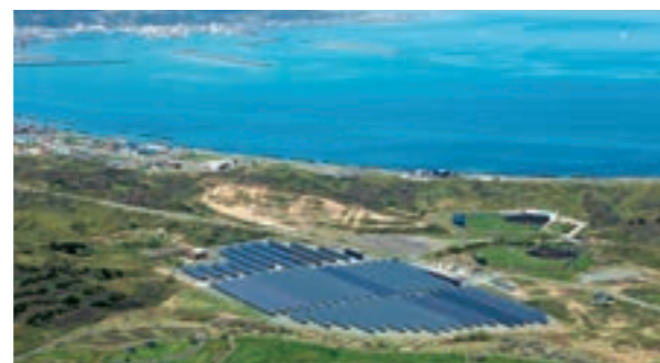
稚内メガソーラー発電所(稚内市)
