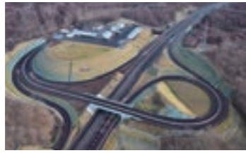
苫小牧中央インターチェンジ
